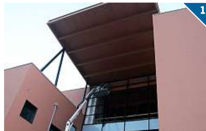
L'INVOLUCRO. Il montaggio dei serramenti e la chiusura dell'involucro sono previsti entro fine anno, con il montaggio di facciate continue lato Nord (ingresso di via Fiorentini) e Sud (giardino), in corso in questi giorni.
